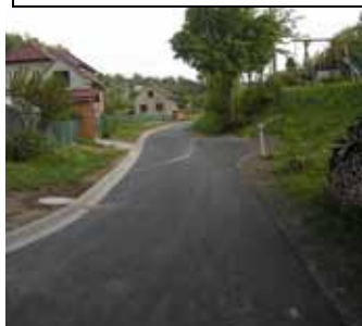
Obec Sebranice, „Stavební úpravy místní komunikace Sebranice“
